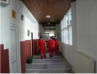
Adaptacija elektro Instalacija u više škola
