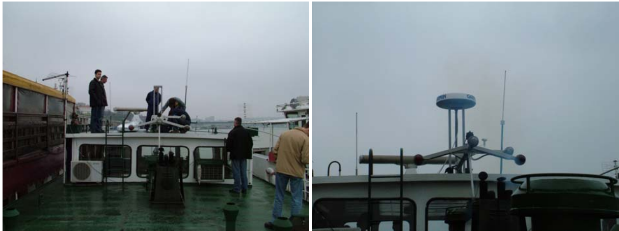
Privremena montaža radara na kabinu broda "Istrajni 1"
